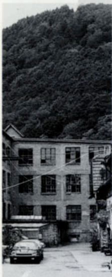
Hofansicht der Schokoladenfabrik mit Blick auf den Hahnberg
